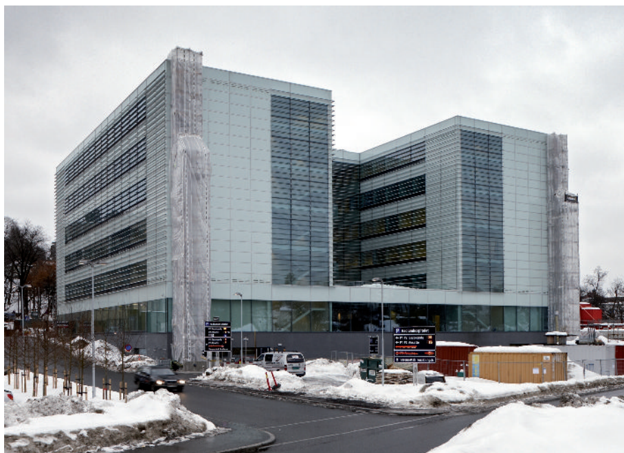
In Oslo haben Henning Larsen Architects einen transparenten Neubau für das norwegische Radium Hospital geschaffen.
